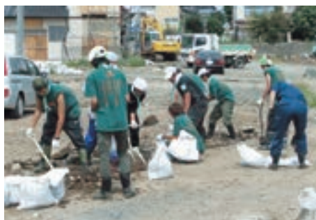
側溝の泥上げをする学生ボランティア。魚介類の死がいなどによる悪臭もかなり強く、大変な作業です。
