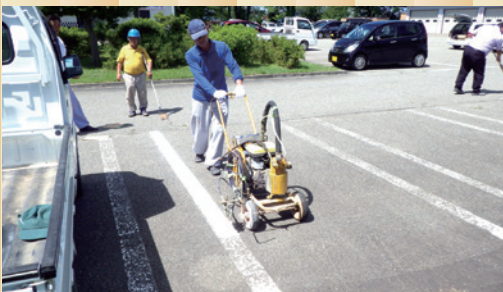
専用塗料が機械で吹き付けられます
